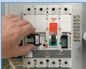
Elektrische accessoires (b.v. hulpcontacten, shunt-trip) gemakkelijk vanaf de voorkant aan te brengen
