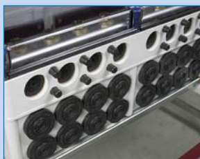
Speciale kabelinvoeringen
